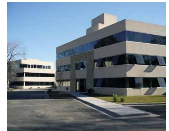
Edificios 1 y 2, con todas sus oficinas vendidas y entregadas a sus nuevos propietarios.
